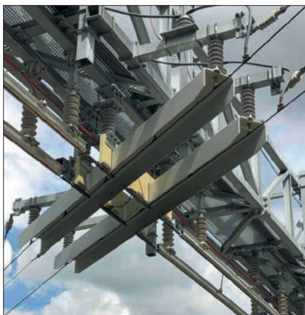
14. ábra: A Friesenberg utcai vasút - trolibusz keresztveződésnél a felsővezeték kapcsolatok kialakítása. A hosszú „dobozok” védik a trolivezetéket a 15 kV feszültségtől. Az áramszedő szénléc elegendő távolságban csúszik át a 600 V trolivezeték alatt. (Fotó: Laczó Ferenc)
