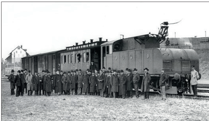
5. ábra: A Seebach-Wettingen egyfázisú, ipari periódusú vontatási rendszerrel villamosított vonalszakasz kísérleti üzemben
