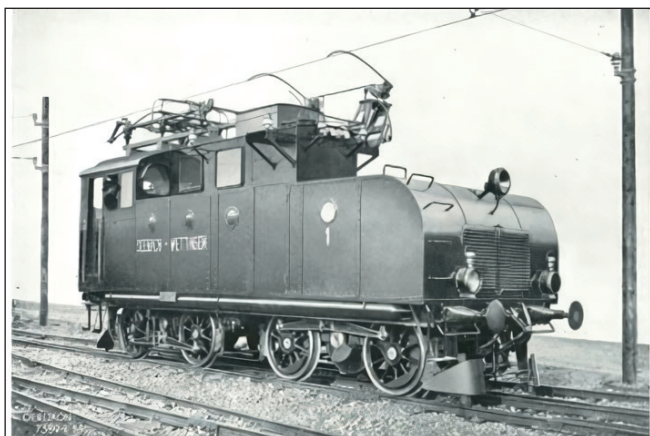
6. ábra: A 1. számú próbamozdony a Seebach-Wettingen vonalon (Oerlikon-gyár, 1904.). A világon az első egyfázisú váltakozó feszültségű és 50 Hz frekvenciájú villamos mozdony
