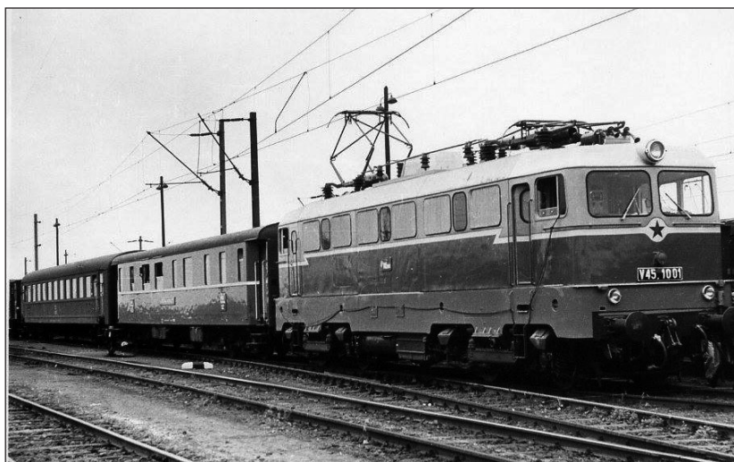
5. ábra V45 1001 kísérleti villamos mozdony a V43 1051 kísérleti UFB-3 forgóvázal 1967-1969-ben a MÁV 152-es pályaszámú vontatási mérőkocsival
