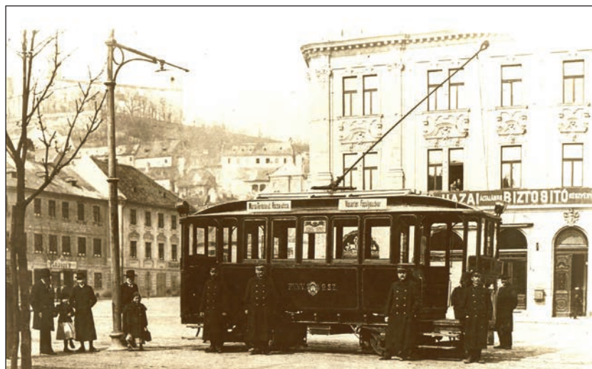
16. ábra: A 9.sz., 1898-ban szállított motorkocsi a Hal téren. A fénykép kelte nem ismert, de még a lírás áramszedők felszerelése előtt (1906-1910?) készült. Jól látható a görgős áramszedő és a tető két oldalán elhelyezett, „Mária Terézia út. Rózsa utca. Vásártér. Főpályaudvar” feliratú iránytábla, valamint a tetőn elhelyezett reflektor.
