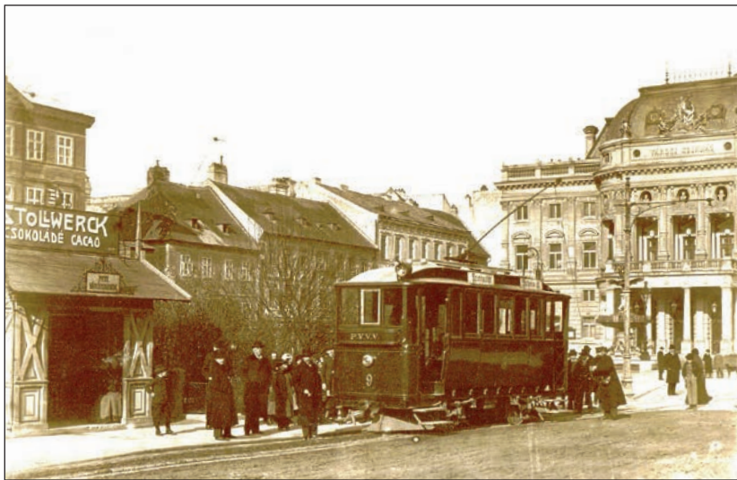
17. ábra: A 9 sz. motorkocsi a Nemzeti Színház előtt, a kocsit görgős áramszedőjének átfordításával az ellenkező irányú menetre készítik. A felvételen látható a homlokfal, a tetőn elhelyezett reflektor, a P.V.V.V. felirat, jelzőcsengő, tányér alakú ütköző, a tető oldalán a „Színháztér. Stefánia út” iránytáblák.
