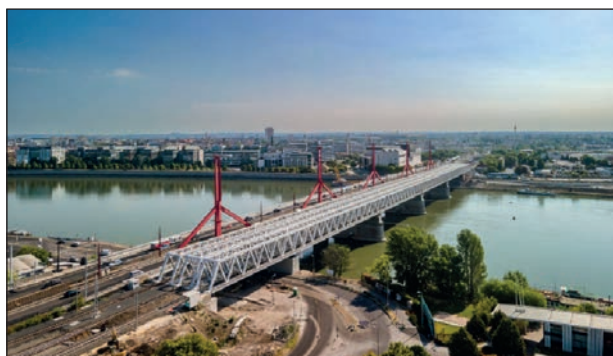
5. ábra: A Déli Vasúti összekötő híd
