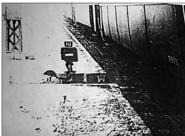
6. ábra: A kitérő irányba állított 11 számú váltó állítóberendezése és jelzője
