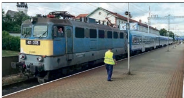
14. ábra: Elkészült a Mezőzombor-sátoraljaújhelyi vonal villamosítása 2020-ban (Fotó: Internet)
