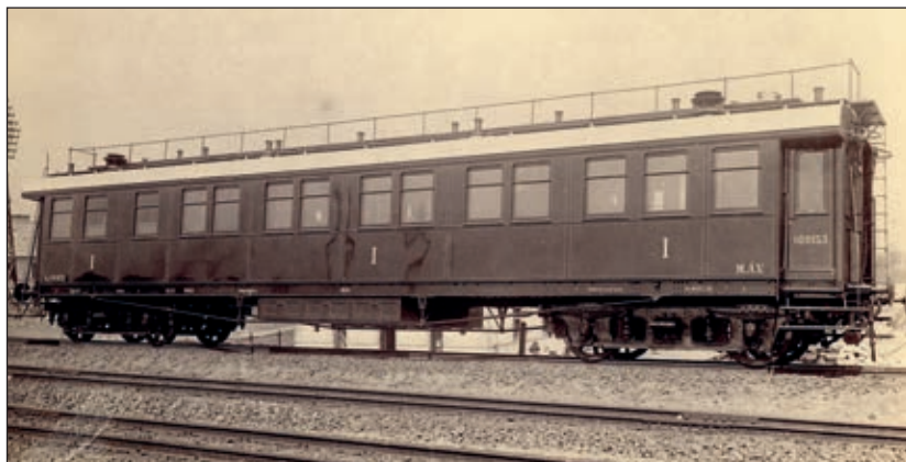
2. sz. ábra: A MÁV IV q jellegű, Ganz gyártmányú, Aa h 100153 pályaszámú első osztályú személykocsija gyártáskori kivitelben. Az eredeti fényképen olvasható a „Budapest keleti p.u.” állomásítási hely és az 1896. február 15-i revízió dátum. Jól megfigyelhető a fényképen a forgóváz hármás rugózása: A keresztthimba, a laprugók és a tekeresrugók. 1898-ban V l 1 jellegű I./II. osztályú személykocsivá alakították „hálóberendezéssel”, ABA h 100501 pályaszámmal. Az első világháború után a Román Államvasutak állagába került, ahol 1929-től CFR A ALD 13033 pályaszámmal közlekedett. (MMKM TFGY 176)
