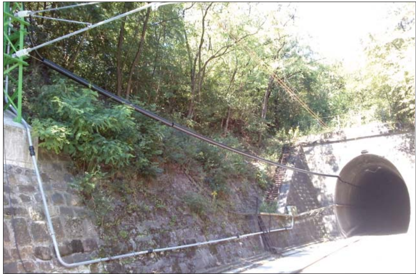
12. ábra: A piliscsabai alagút villamos vontatásra alkalmassá téve (forrás: Szerző)
