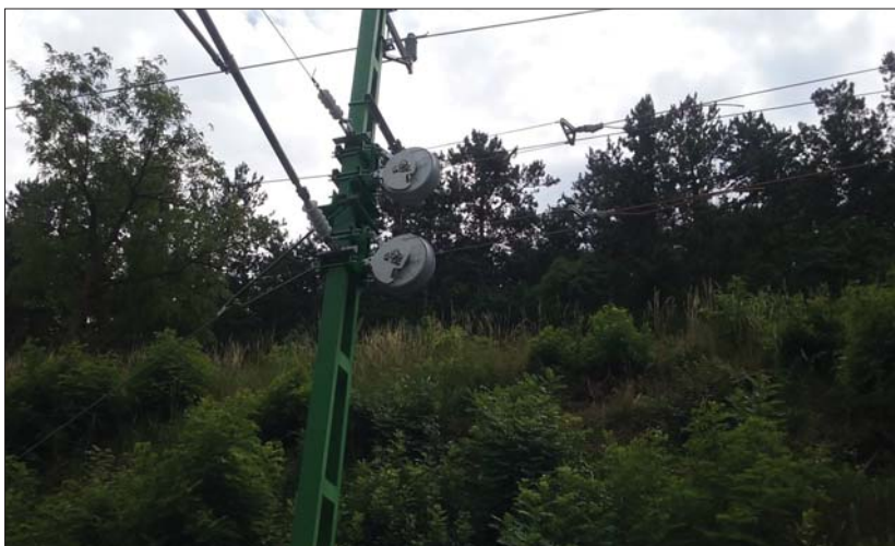
14. ábra: Az esztergomi vasútvonal villamosítása során kis helyigényű rugós feszítőmű beépítésére vált szükségessé (forrás: Szerző)
