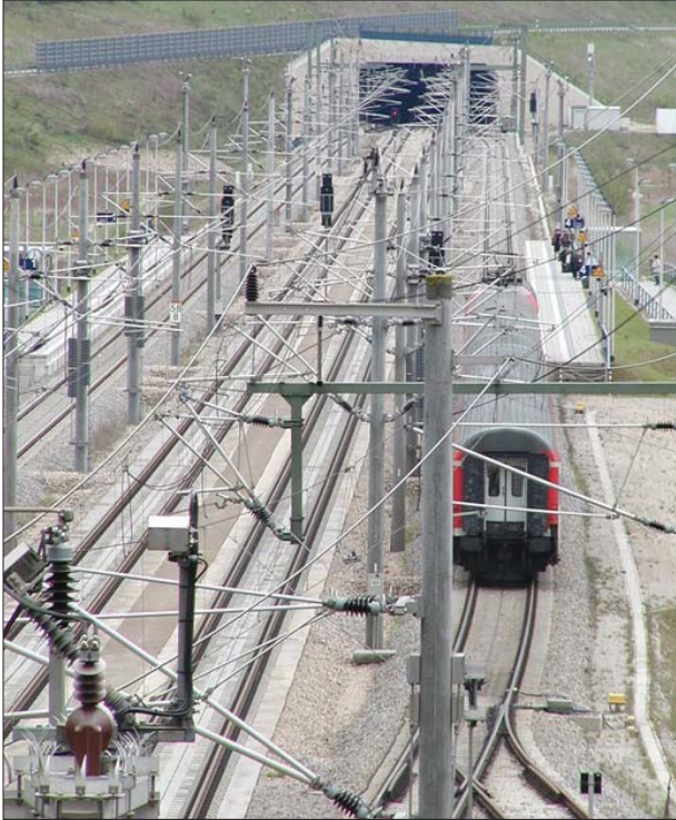
3. ábra: Egyedi vasbeton oszlopokkal alátámasztott állomási felsővezeték (DB, Bajorország, Kinding)
