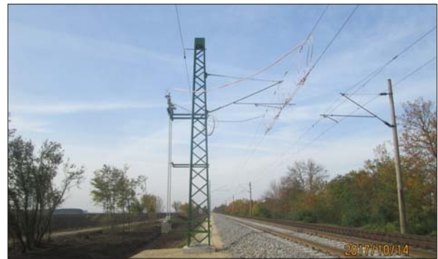
9. ábra: Elválasztó fázishatár szakaszszigetelés szerelés alatt Karcag és Ebes állomás táplálás
