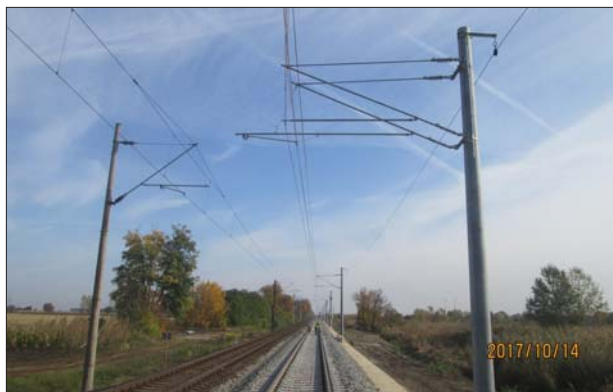
10. ábra: Vonali szakaszolás kettős tartószerkezet és fényvezetőszálás optikai kábel BM tip. oszlopon
