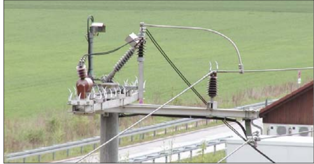
4. ábra: Vákuum megszakító szakaszkapcsoló
