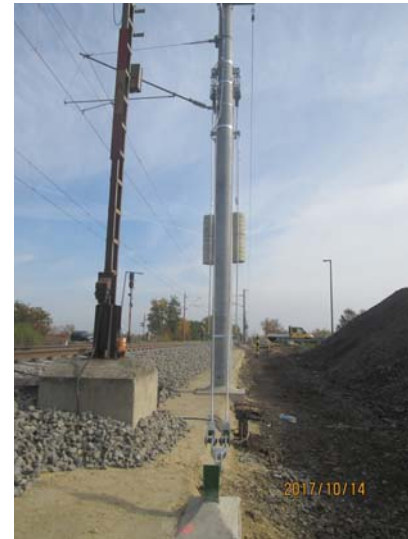
8. ábra: A hosszslánc feszítőmű a lehorgonyzástól nézve
