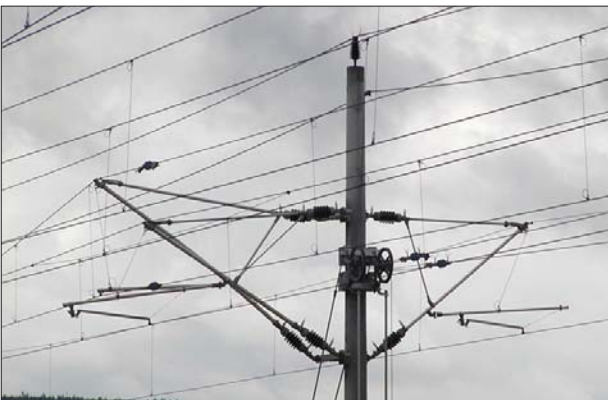
6. ábra: A madarak leszállását akadályozó tüskék a DB vasúti felsővezeték hálózatán
