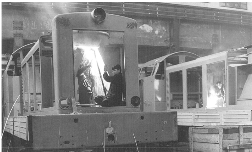
2. ábra DHM3 prototípus mozdonyok járműszerkezetének építése Abb. 2.: Bau der Fahrzeugkastens der DHM3-Prototyplokomotiven Fig 2 Construction of vehicle structure of prototype DHM3 locomotives
