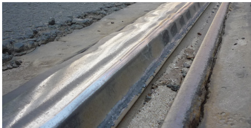
2. ábra Egy R=63 m sugarú ívben kialakuló vegyes típusú sinkpások
