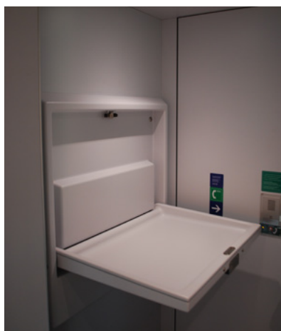
5. ábra: A kerekesszékekkel járható és pelenkázó asztallal felszerelt mozgássérültek használatára méretezett, nagyméretű WC (Fotó: Kovács Károly) Abb. 5 Das für Rollstuhlfahrer begehbare und mit Wickeltisch ausgerüstete Großraum-WC (Aufnahme: Kovács, Károly) Fig 5 Large-sized toilette of special areas for wheelchairs designed to use for persons with disabilities and reduced mobility and equipped with baby nappy changing facilities. (Photo: Károly KOVÁCS)
