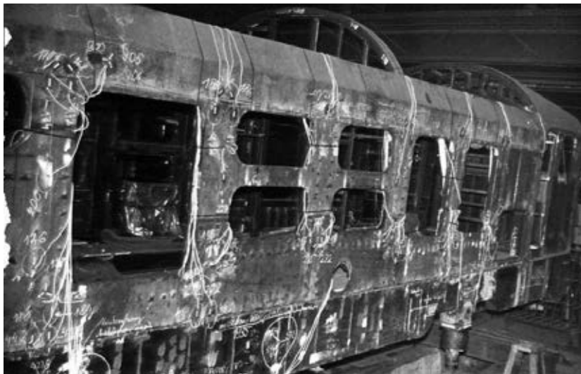
10. ábra: A 404 gyári számú mozdony tenzometrikus mérése
