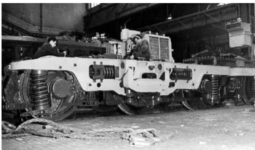
6. ábra: A készre szerelt forgóváz a Ganz-MÁVAG szereldejében
