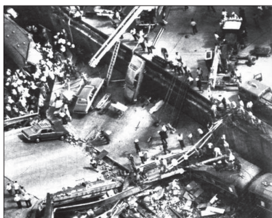
5. ábra A leszakadó Bold-Street acél-beton híddal együtt leesett autósok túlélték a balesetet
