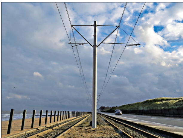
17. ábra Költségtakarékos felsővezeték oszlop konstrukció
