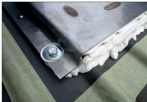
2. ábra: Tetőegység beépítés előkészítése
