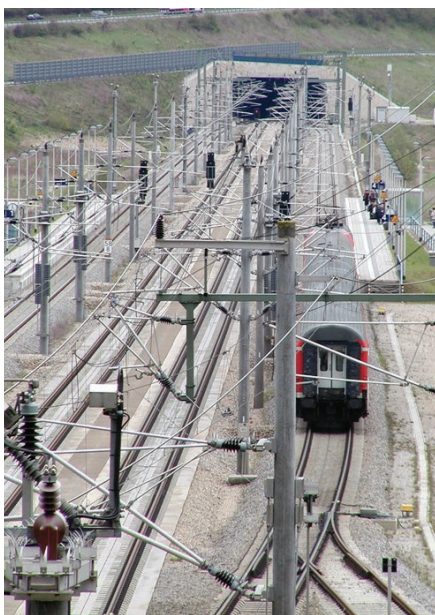
11. ábra: Német példa vasútállomás pörgetett betonoszlopokkal történő villamosítására
