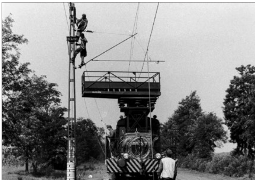
2. ábra: Felsővezeték építése korabeli fotón
