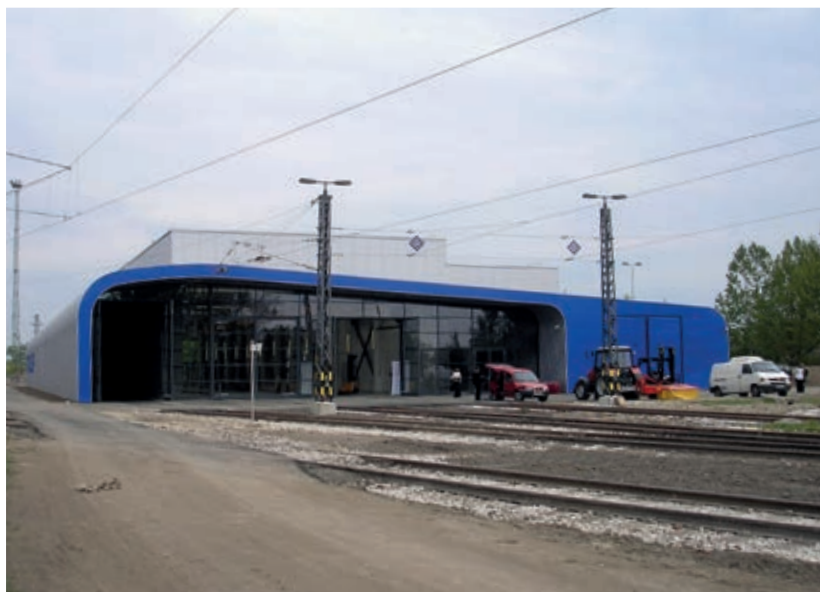
18. ábra: Püspökladányi Karbantartó bázis a mosóvágánya bevezetett 25 kV-os felsővezetékkel
