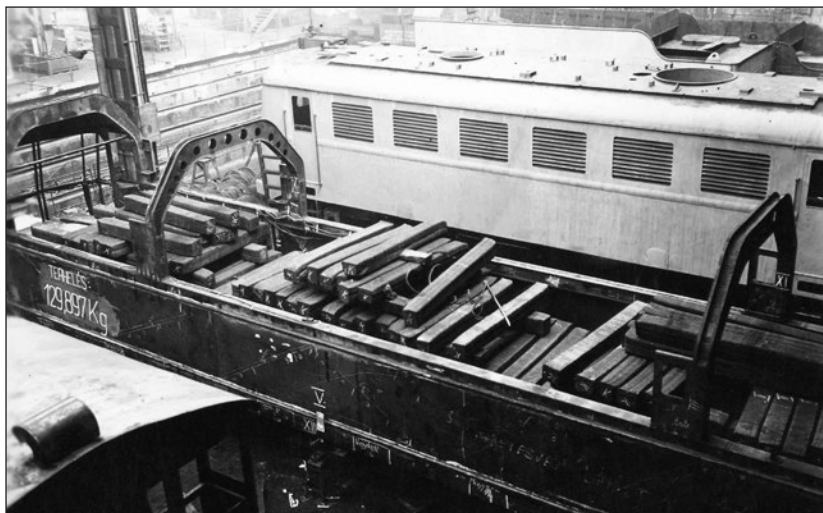
18. ábra: Terhelési próba a DVM3 vázszerkezete
