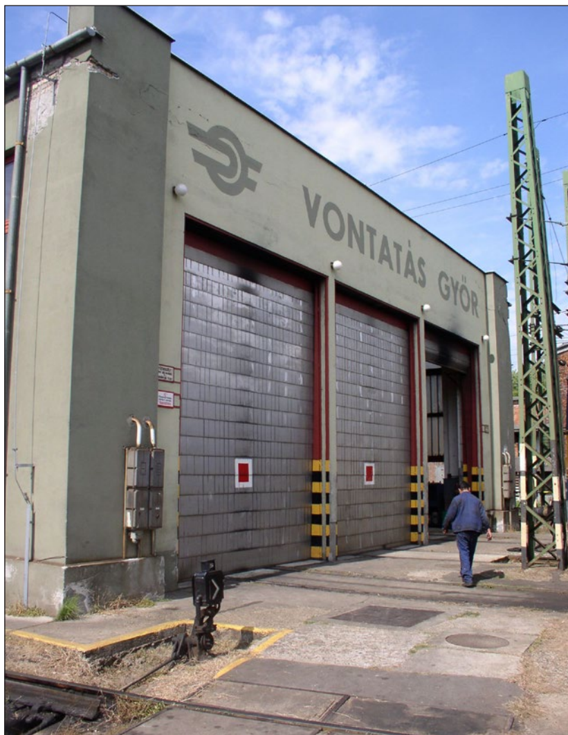
10. ábra: Győr fűtőház
