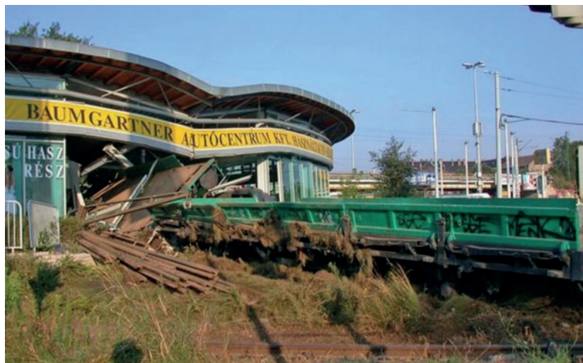
1. ábra: A kisiklott és oldalára dőlt vasúti kocsi az autószalonnak ütközése után (katasztrófavédelem képe)
