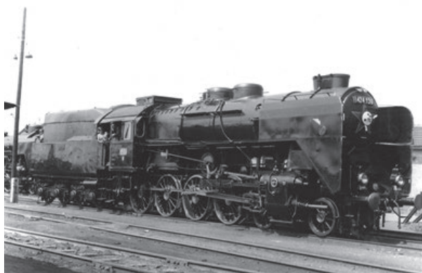
18. ábra Pakuratüzelésre átalakítva, füstterelő lemezekkel és csillagfűvós kettőskéménnyel felszerelve és az Antidur kazán tápvíz kezelési eljárás víztisztító nélküli alkalmazására felkészítve.
