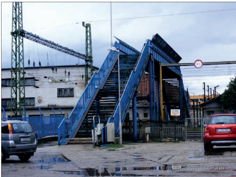
8. ábra: Szombathely állomáson a villamosítás átadása előtt szükség volt egy új gyalogos felüljáró építésére. Ez 25 éves műtárgy
