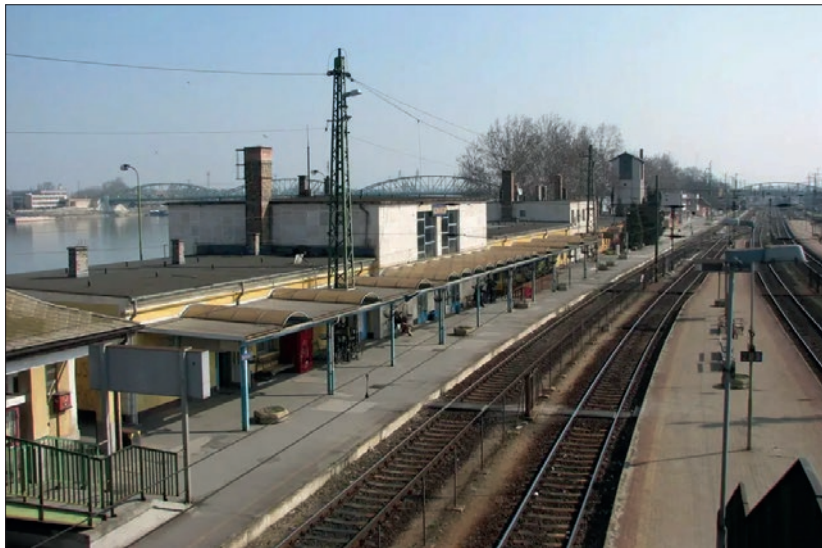
3. ábra: Komárom állomás és környékének átépítése, nyomvonal korrigálás nélkül valósult meg, lassítva a vasúti közlekedést
