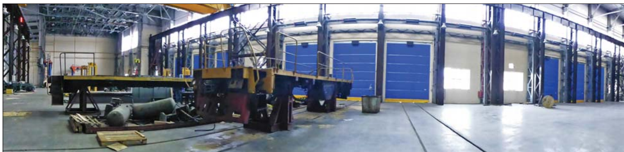
5. ábra: Panorámakép a modernizált csarnokról Fig 5: Panoramic view of the modernized assembly hall Фото 5: Обновлённый цех
