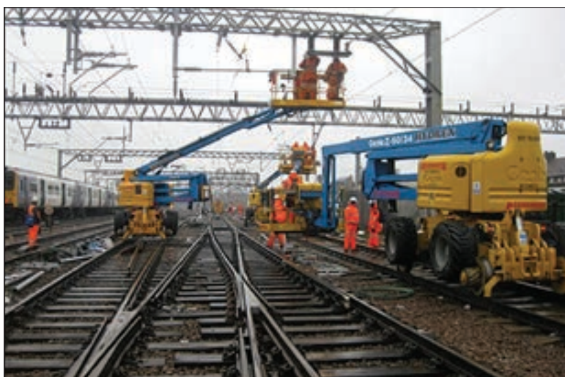
10. ábra: Váltóközvet felsővezeték rendszerének gyors kiépítése
