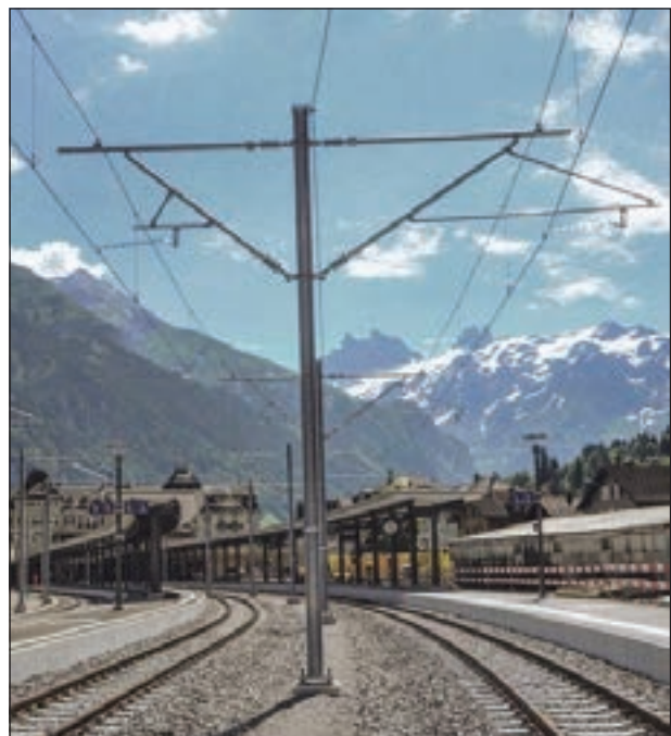
6. ábra: Állomási példa a takarékos felsővezeték oszlophelyezésre
