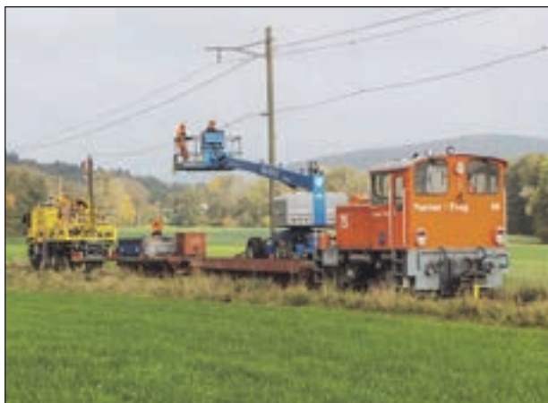
7. ábra: Svájci felsővezeték építési megoldás
