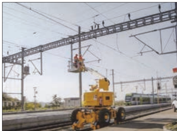
8. ábra: Svájcban kétlétű felsővezeték szerelő jármű dolgozik
