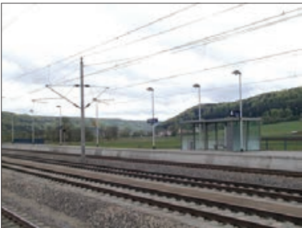
5. ábra: Kinding állomás Németország, letisztult, takarékos oszlop kihelyezési példa és szélfúvás elleni tartószerkezeti megoldások
