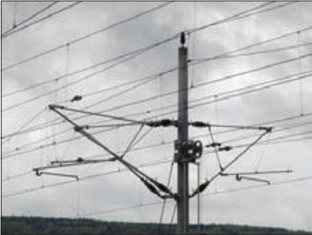
3. ábra: Madarak leszállását megakadályozó tűskék a DB-nél.
