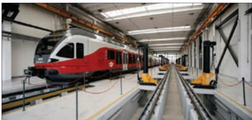
4. ábra: A pusztaszabolcsi motorvonat karbantartó bázis munkaterülete Abb. 4.: Der beispielhafte Arbeitsbereich der Instandhaltungsbasis für elektrische Triebzüge in Pusztaszabolcs Fig 4.: The Pusztaszabolcs EMU maintenance depot as a good example
