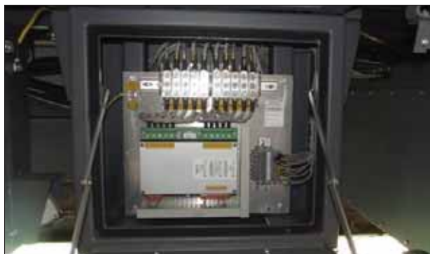
4. ábra: Az MMBC sínfék vezérlő beépítése Abb. 4: MMBC-Schienenbremssteuergerät – Einbau Fig 4. The installation of the MMBC type rail brake controller unit.
