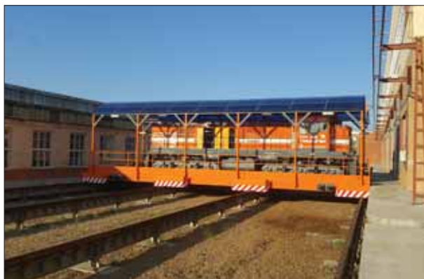
19. ábra: Az elkészült tolópad pálya, hidján az első TEM2 mozdonnal Fig 19: Transfer table tracks after completion with the first TEM2 locomotive on it
