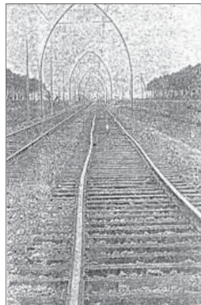
1. c ábra: A rekordkísérlet következtében deformált vágánymező
