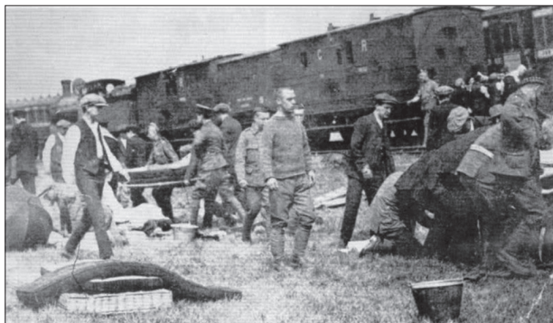
2. ábra 1915. május 22., Quintinshill vonatbaleset, sérült kocsi Abbildung 2. 22 Mai 1915. – Eisenbahnunfall in Quintinshill, beschädigter Wagen
