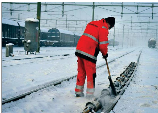
5. ábra/Abb. 5./Fig. 5. Hó eltakarítás kézzel, egy svéd rendezőpályaudvaron Fotó: Mobil.hd.se
