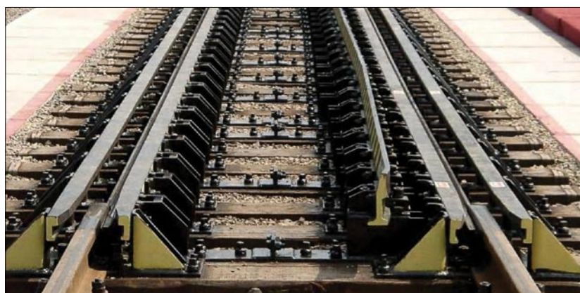
3. ábra A nyomtáv-váltó sínszakasz Abbildung 3. Spurwechsel-Gleisabschnitt Figure 3. The gauge changer rail segment
