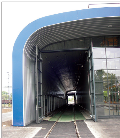
14. ábra A járműmosóban a vonat 25 kV feszültség alatt önjáróan közlekedhet
