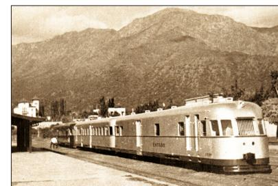
7. ábra Az Argentin Államvasút (Estado) megrendelésére szállított 72 motorvonat egyike
