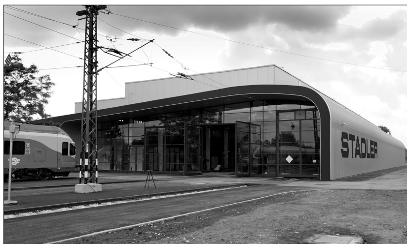
2. ábra STADLER karbantartó telep Pusztaszabolcson
