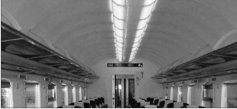
15. ábra Az utastéri világítás Abb. 15. Fahrgastraumbeleuchtung Fig. 15. Saloon lighting
