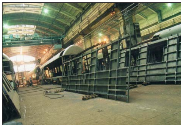
27. kép: Előre gyártott oldalfalak
