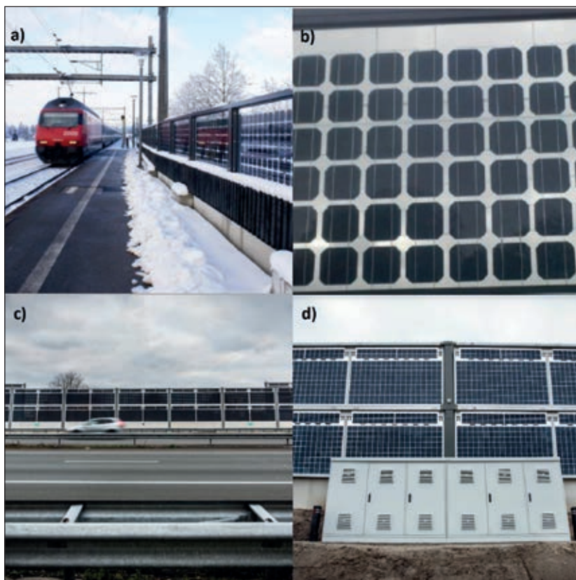
1. ábra: a) és b) kétoldalas napelemes vasúti zajvédő fal Münsingenben; c) és d) kétoldalas napelemes zajvédő fal Uden közelében az A50-es autópálya mentén (Forrás: T. Nordmann et al. 2012, M. de Jong. 2015 és heijmans.nl 2019)
