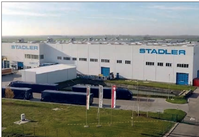
4. ábra: Stadler Szolnok Vasúti Járműgyártó Kft. székhelye Szolnokon
