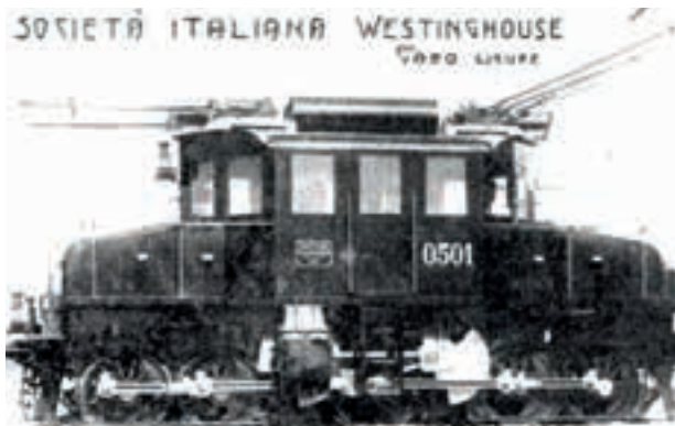
4. ábra: A képen az E550, amely egy Kandó által tervezett és a Ganzban gyártott ötcsatlós „Giovi” vagy „Cinquanta” mozdony.
