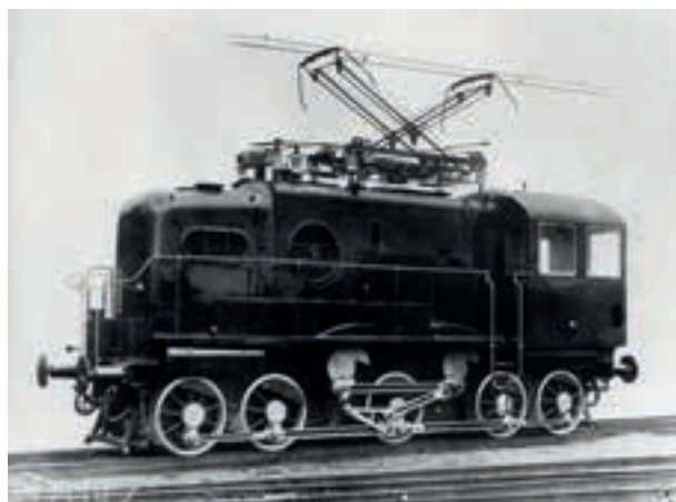
7. ábra: 1923-ban 15 kV-tal villamosították a Budapest Nyugati pu. - Dunakeszi-Alag vonalat, a próbákat a VM 5 típusjelű E tengelyrendezésű villamos mozdollyal végezték. 1928-ra átépítették, a próbamozdony a MÁV-tól a V 50.001 pályaszámot kapta.
